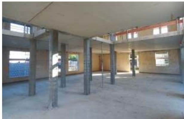
Aktueller Stand der Arbeiten im Innenbereich
